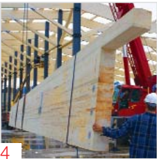
4 Fijando el techo
