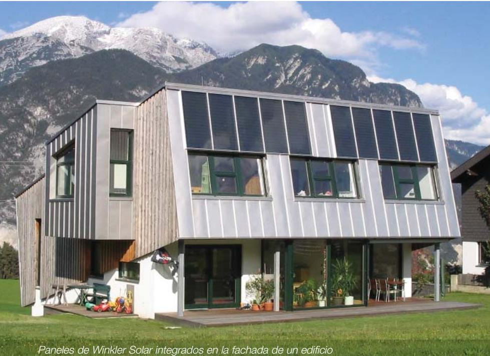
*Paneles de Winkler Solar integrados en la fachada de un edificio*
