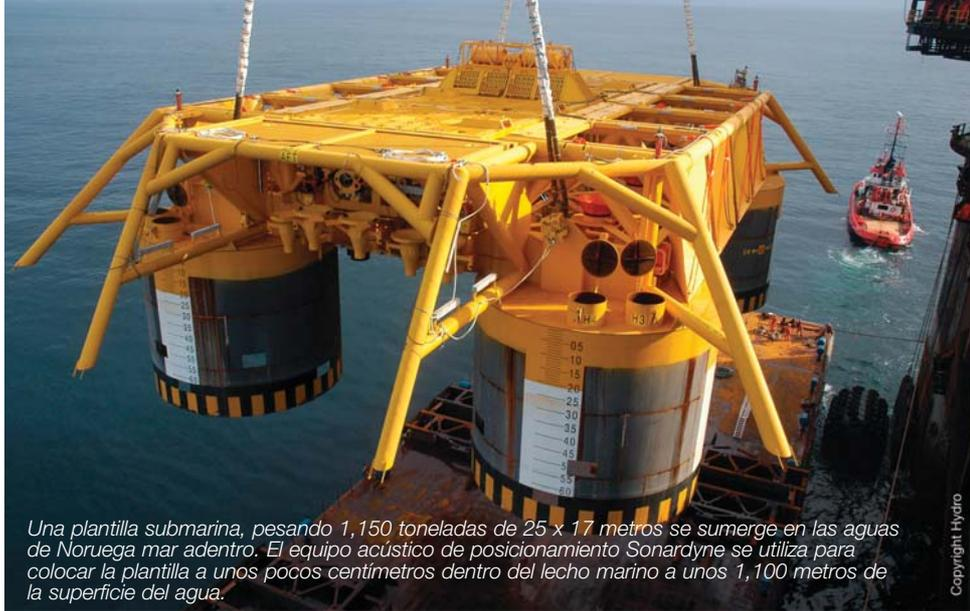
Una plataforma submarina, pesando 1,150 toneladas de 25 x 17 metros se sumerge en las aguas de Noruega mar adentro. El equipo acústico de posicionamiento Sonardyne se utiliza para colocar la plantilla a unos pocos centímetros dentro del lecho marino a unos 1,100 metros de la superficie del agua.
