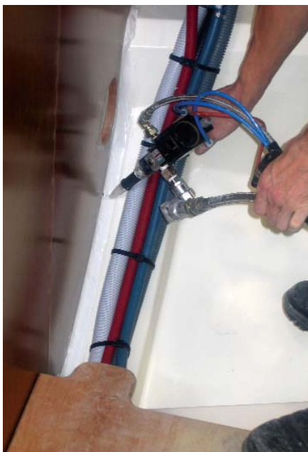
Aplicando el adhesivo "boosted"
